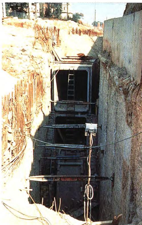
Imagen de la construcción de la red de galerías de servicios de Barcelona. Tal y como preveía el Plan, se han construido un total de 30 Km.
